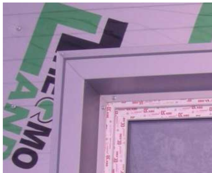
Рис.10. Сопряжение бокового и верхнего нащельников окна.
